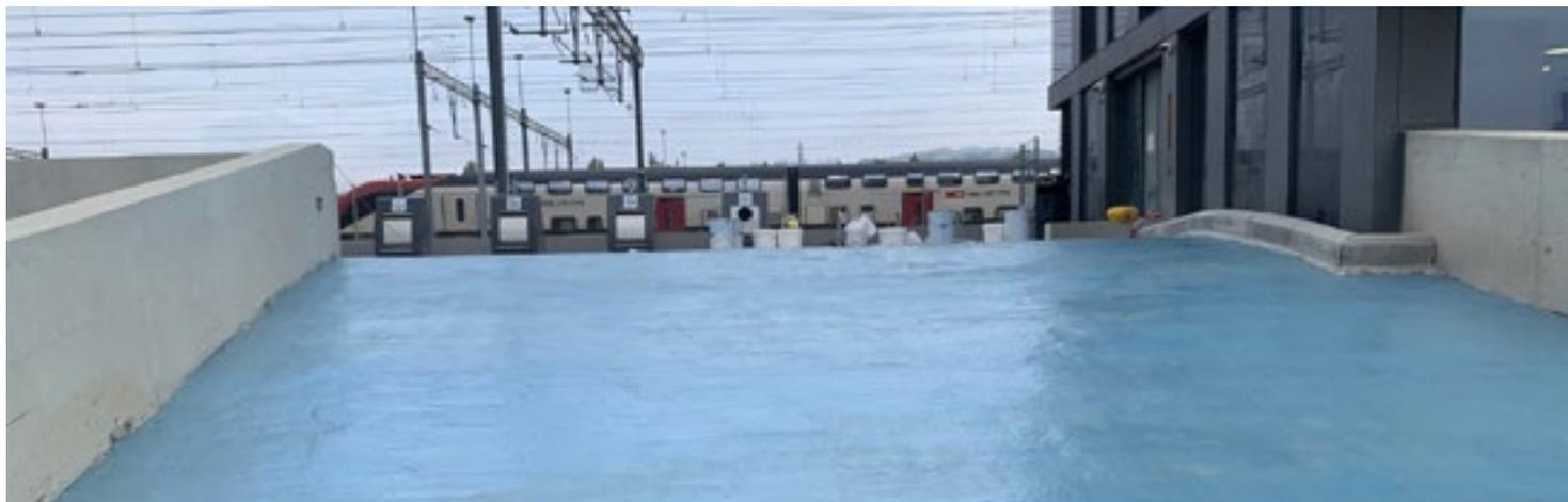
Système d'imprégnation et de saturation sur support en béton, primaire PMMA flamme à séchage très rapide.
