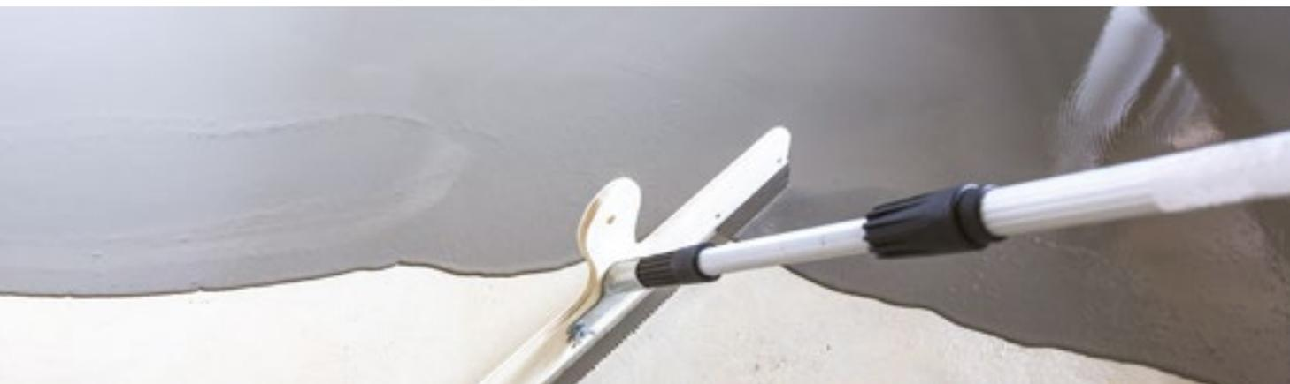
Revêtement de sol autolissant souple de 3 mm à base de polyuréthane, à faible émission de COV, pour sols polyvalents sur supports béton, destiné aux locaux publics et parapublics (salles polyvalentes, halls d'exposition).
