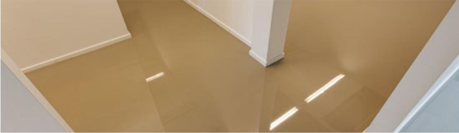
Revêtement de sol autolissant à base de polyuréthane semi-rigide de 3 mm, à faible émission de COV, pour sols industriels et polyvalents sur supports béton et enrobés percolés, destiné aux industries pharmaceutiques/alimentaires/mécaniques, aires de stockage et de circulation intensive, restaurants d'entreprise, locaux techniques, archives, locaux publics et parapublics (salles polyvalentes, halls d'exposition). **Classement de réaction au feu, CSTB = Cfl-s1.**
