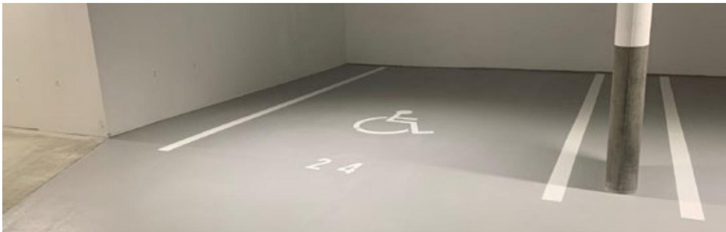
Système de revêtement de parking à base de résine époxy peu solvanté, très économique et à forte résistance mécanique. **Type OS 8.**
