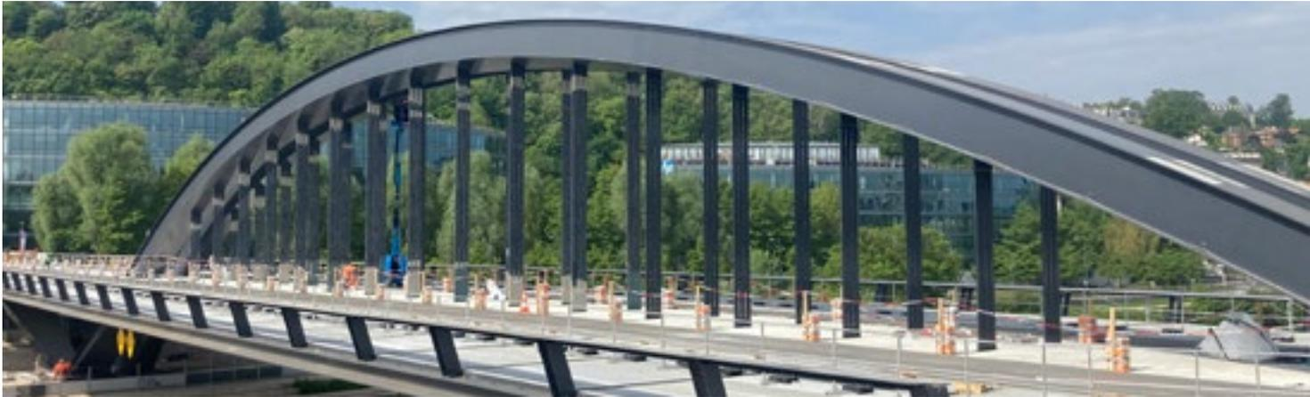
Système d'Étanchéité Liquide (S.E.L.) à base de résine époxy-bitume bi-composant pour les tabliers de ponts en acier, passerelles et autres supports métalliques à étancher. **Avis Technique CEREMA OUVRAGES D'ART N°F AT ET 18-04, validité 12/2023. Selon les normes VSS 40451 Étanchéité de pont métalliques.**
