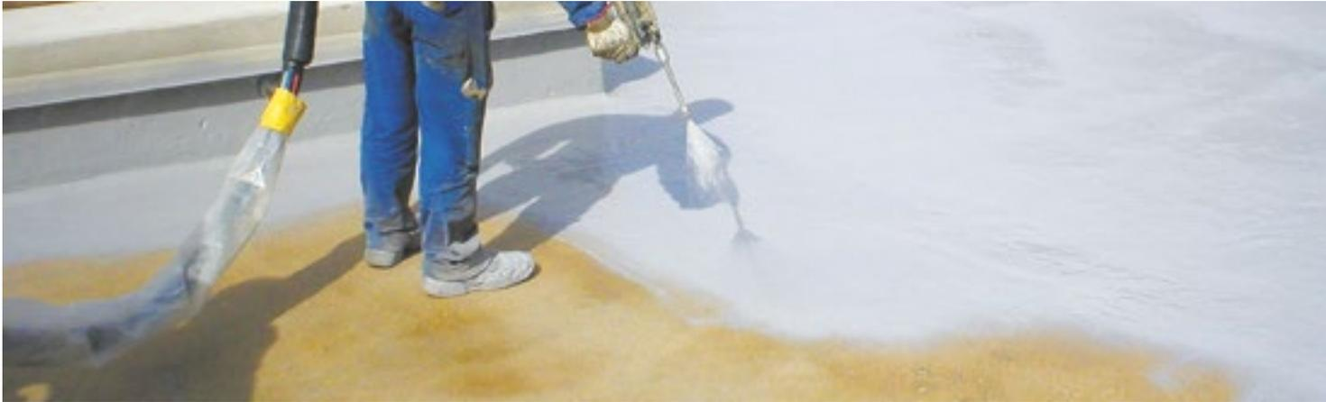
Système d'Étanchéité Liquide (S.E.L.), à base de résine polyuréthane bi-composant projetée à chaud à l'aide d'une machine de projection, destiné à l'étanchéité des toitures contre la pénétration des eaux de pluie, sur support béton, acier, autres supports nous consulter. Le système est destiné aux toitures inaccessibles, aux toitures techniques, aux toitures accessibles piétons et véhicules légers, véhicules de secours, aux toitures végétalisées\*, aux gradins de stades et aux locaux couverts.
