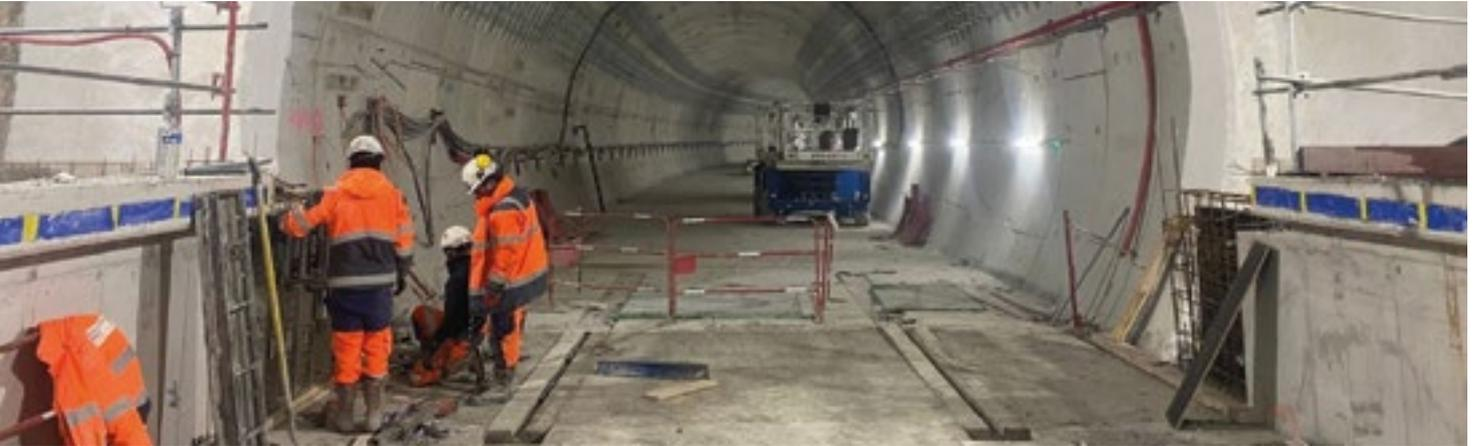
Revêtement d'étanchéité liquide armé à base de résine époxy bi-composant sans solvant destiné aux ouvrages souterrains neufs ou en rénovation, tels que stations de métro, gares, parkings et autres espaces enterrés: tunnels, passages souterrains sous plateforme routière et ferroviaire, tranchées couvertes.
